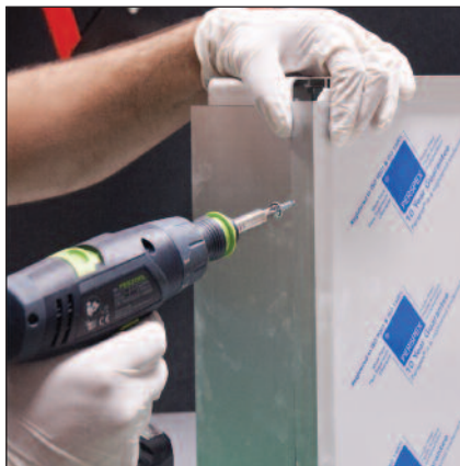
Fissaggio cornice angolare
